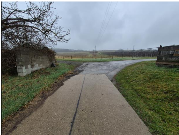
József Attila utca és 053/48 hrsz-ú út csatlakozása
